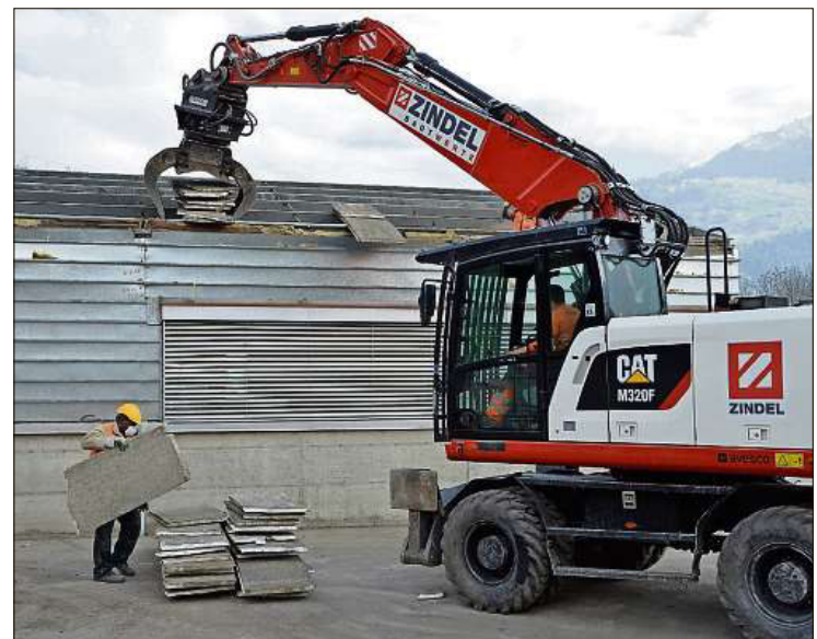
Auf der Baustelle wird rege gearbeitet.
